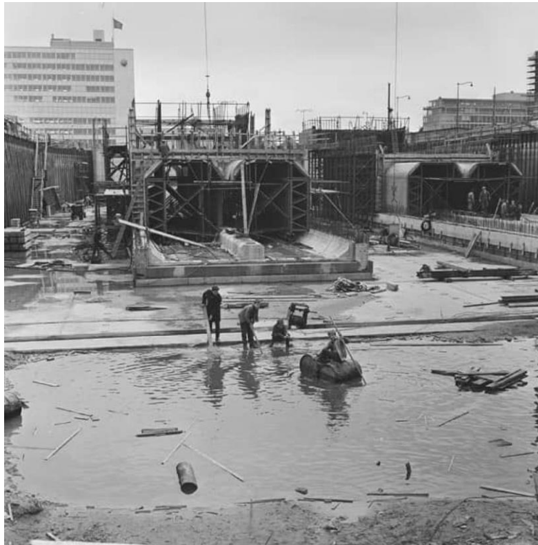
Foto Platform wederopbouw Rotterdam (aanleg metro)
